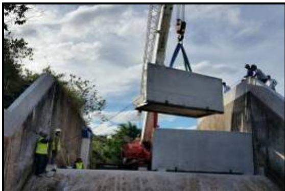
Foto 3 - Vista de montante do assentamento dos Fusegates.
