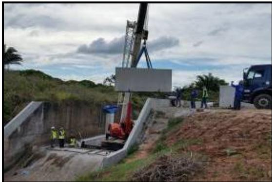
Foto 1 – Vista da base de assentamento dos Fusegates.
