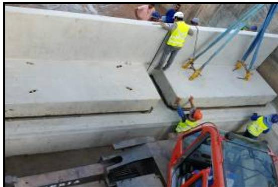
Foto 4 – Fusegate assentado, visto de montante.
