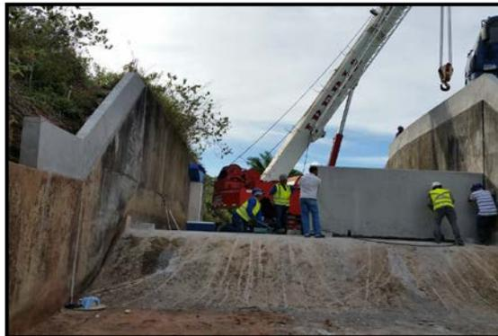
Foto 2 – Vista de jusante do assentamento dos Fusegates.
